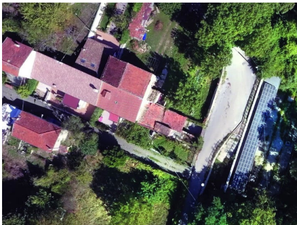
Gagliano Aterno (Aq), uno dei due impianti fotovoltaici della comunità energetica rinnovabile
